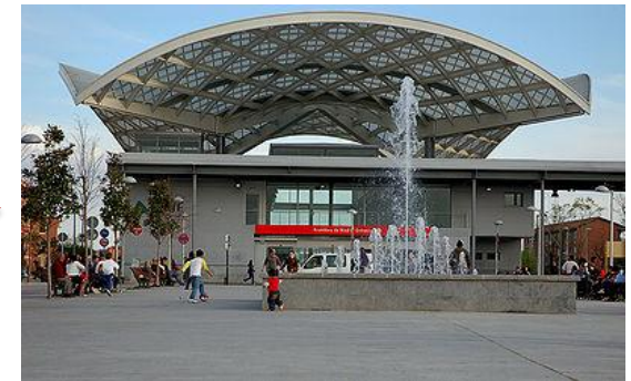
Estación de Renfe - Entrevías
